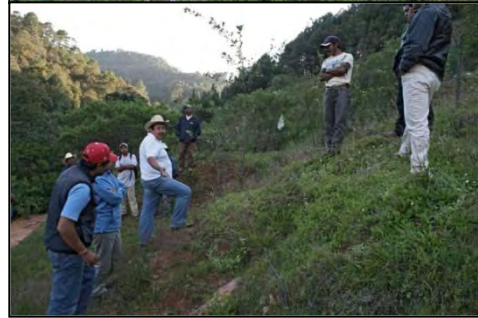
Predio con obras de suelo
